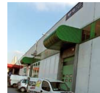
Nuovo centro logistico di Brembate
