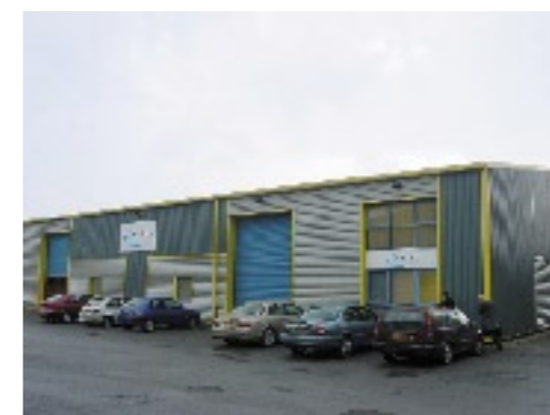
Magazzino Fersina Systems (esterno)
