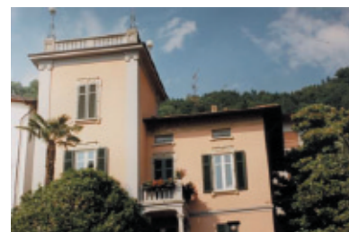
Ristrutturazione di palazzo residenziale
